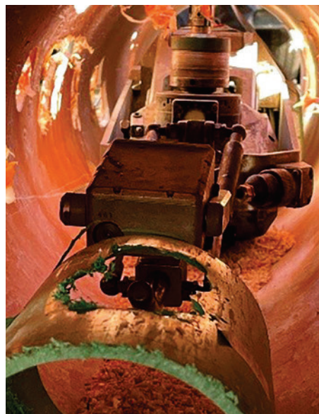
Eigene Aufnahmen Pipetronics – Multi-Roboteranlage
