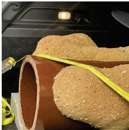
Eigene Aufnahmen „Janßen Umwelttechnik – Janßen-Process“
